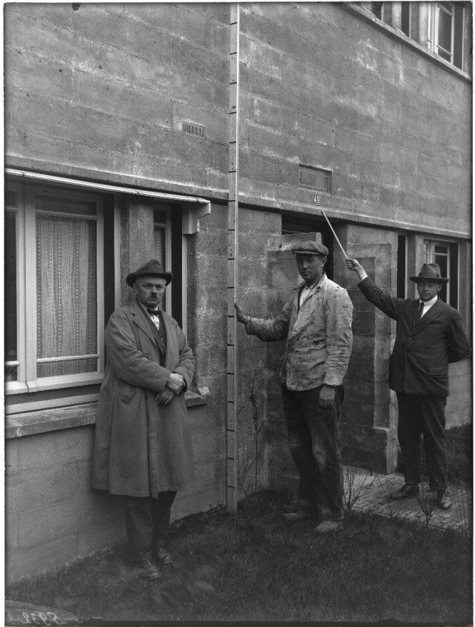
Figuur 9 Inspecteur constateert betonrot
